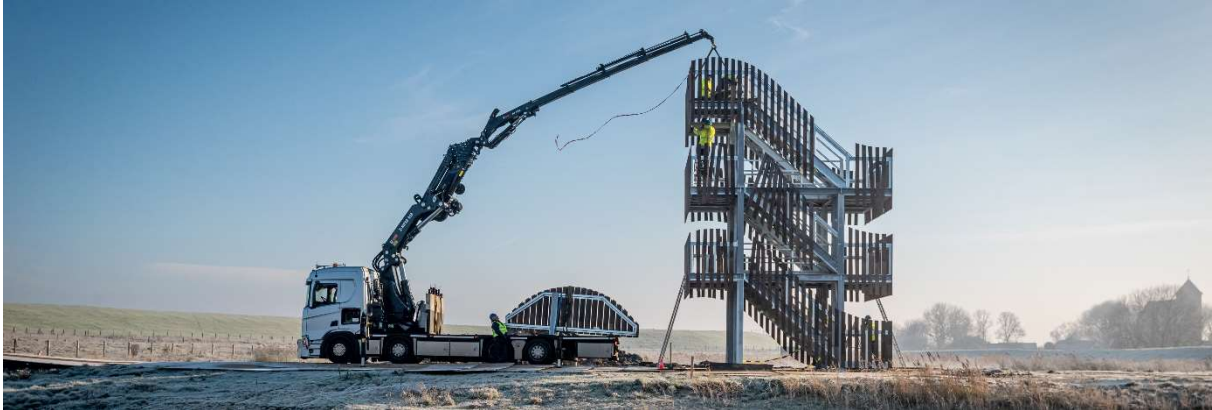
Bouw van uitkijktoren 'Golf van Termunterzijl' door bedrijfsvriend Bosker in 2022
